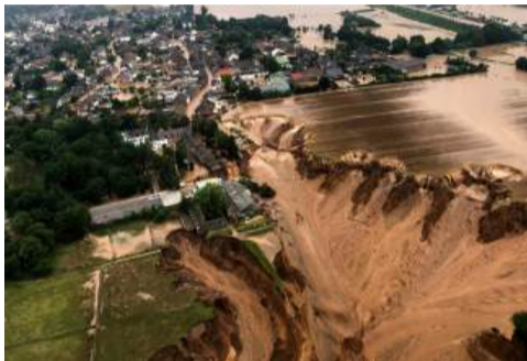
Figure: Erftstadt-Blessem, Germany, July 2021
